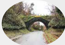
ヒヨドリトンネル
