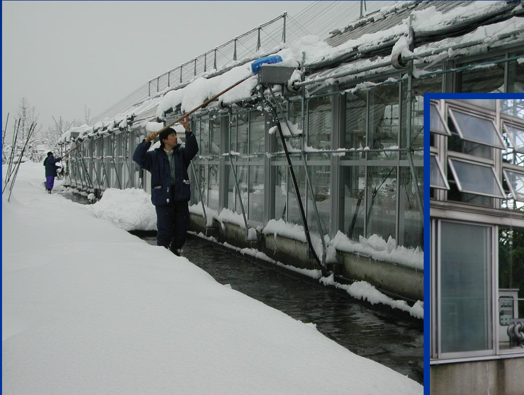
屋根水下側の融雪溝
