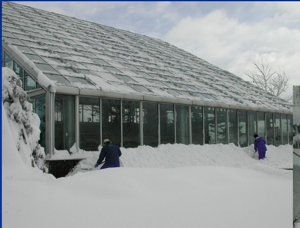
高山植物室の除雪作業
