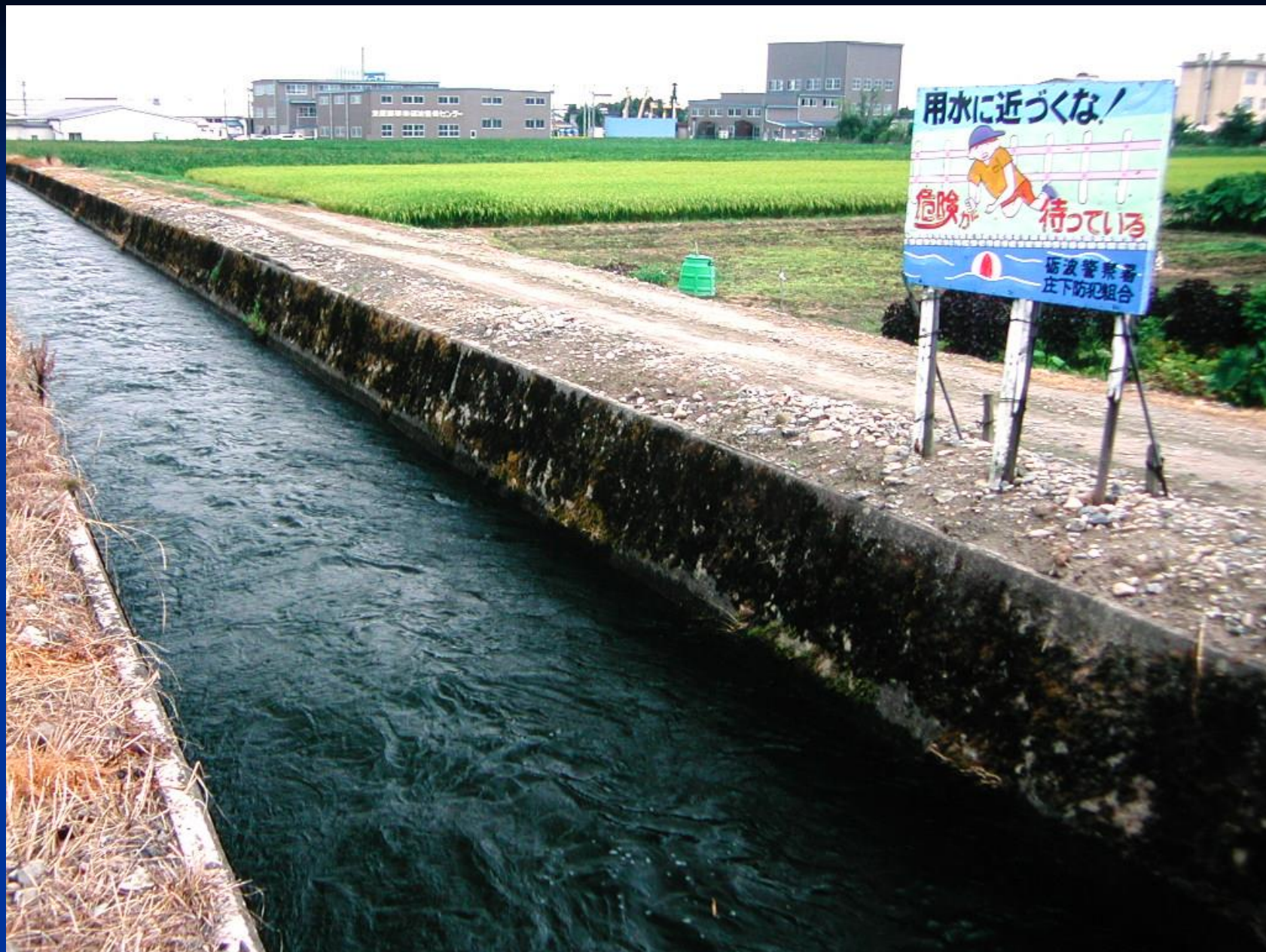
3面コンクリートの“効率のよい”用水路
